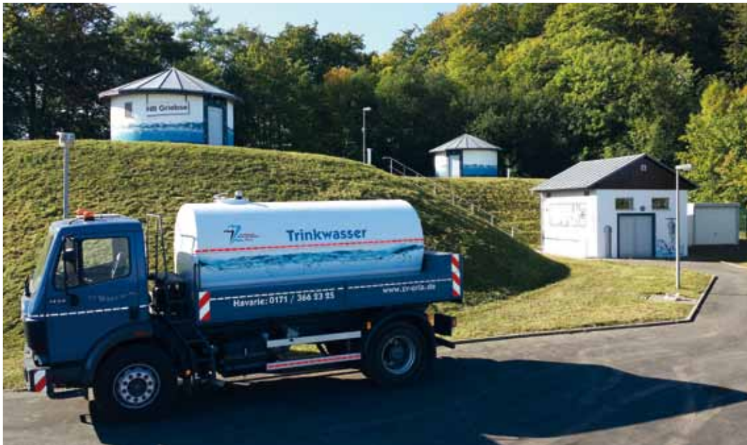
Trinkwasserbehälter Griebse im Versorgungsgebiet Pößneck Fotos: ZVWA Orla
