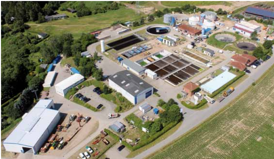
Kläranlage Grevesmühlen, 4 große und 27 kleinere Kläranlagen sorgen im Verbandsgebiet für eine umweltgerechte Abwasser-aufbereitung. Fotos: Zweckverband Grevesmühlen
